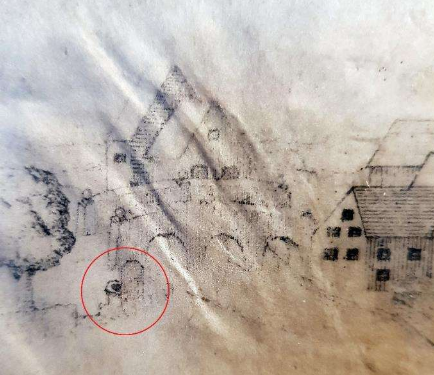
„Nepomuk-Brücke“ und „Padulus-Quelle“, 1719
