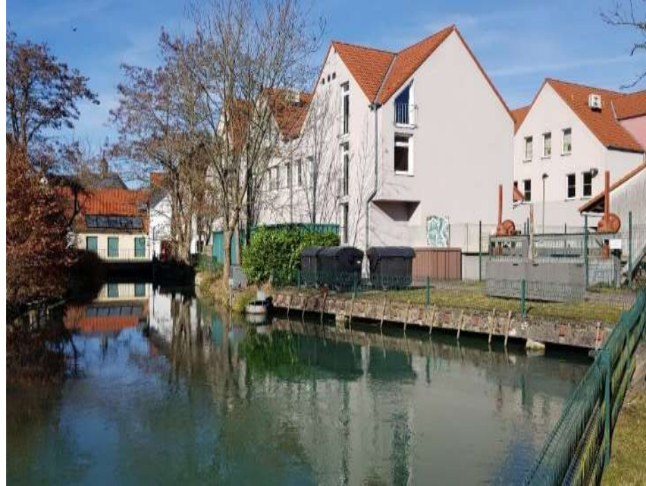
Stauwehr an der Mühlenpader
