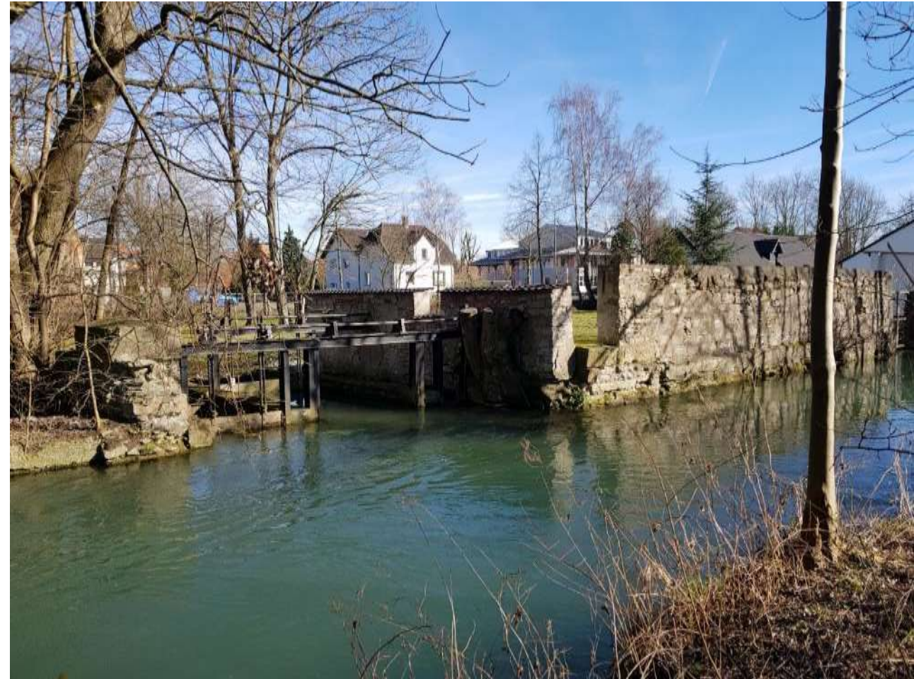
Stauwerk der ehemaligen Walkemühle, Mai 2019 (Foto: M. Ströhmer)
